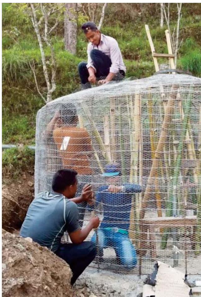
Realizzazione di un serbatoio in ferro-cemento
