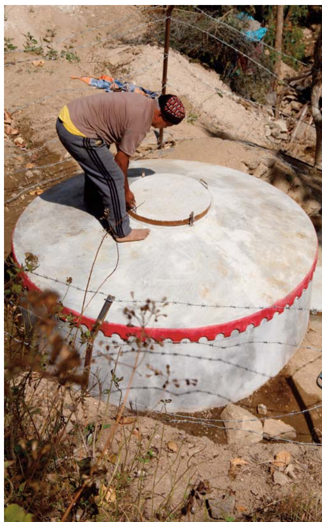
Realizzazione di un serbatoio in ferro-cemento
